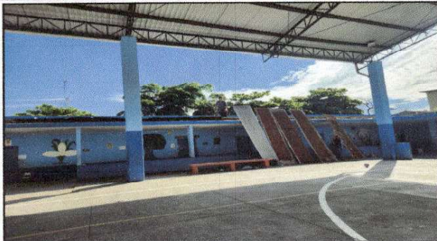
Foto 1: Sustitución de lámina por lámina troquelada, calibre 26
