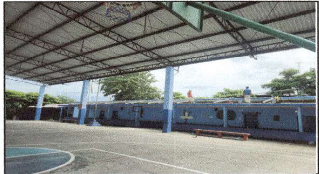
Foto 4: Sustitución de lámina por lámina troquelada, calibre 26
