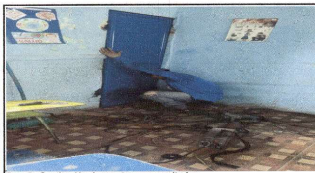
Foto 5: Sustitución de puertas para sanitarios
