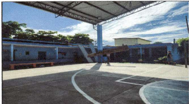
Foto 3: Sustitución de lámina por lámina troquelada, calibre 26
