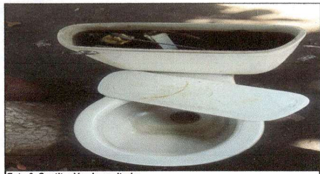
Foto 6: Sustitución de sanitario
