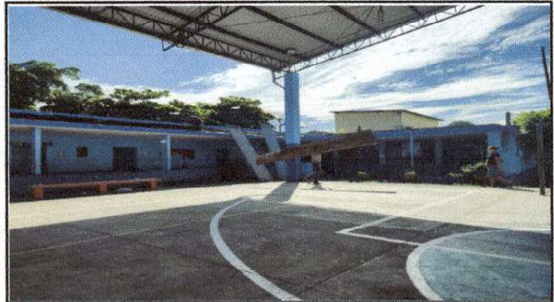
Foto 2: Sustitución de lámina por lámina troquelada, calibre 26
